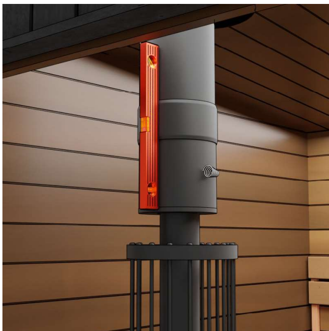
13. Controleer of de schoorsteen mooi recht staat. Verplaats indien nodig de kachel.
