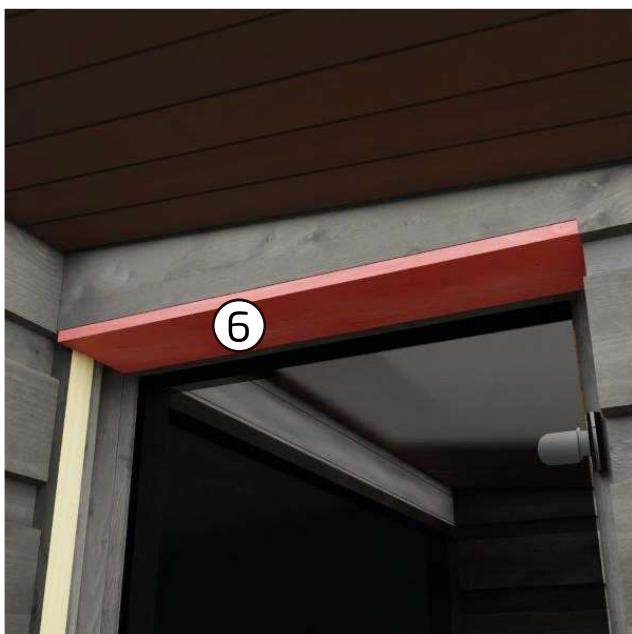
12. Bevestig de korte afdekplaat ( 6 ) boven op de deuropening. De afdekplaat wordt tegen het kozijn van de sauna geplaatst.
